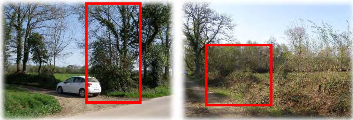
Figure 93 : Illustration des portions de haies à supprimer pour permettre l'accès à E2 (à gauche) et E3 (à droite).
